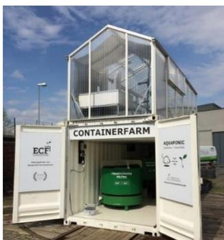
Protótipo produtivo da Efficient City Farming (ECF) integrando a aquicultura em contêiner com hidroponia em estufa em Berlim
