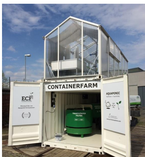
Prototipo di container testato da Efficient City Farming (ECF) per acquacoltura in container ed idroponica in serra. Fonte: ECF Farmsystems Berlin
