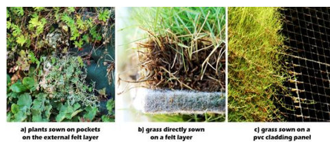
Differenti metodi di ancoraggio delle piante alle strutture di pareti verdi estensive (Mazzali et al., 2013)
