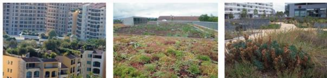
Sistema intensivo per coltivazione su tetto a Monaco (sinistra), estensivo a Dardilli (al centro) e semi-intensivo a La Rochelle, Francia (destra)
