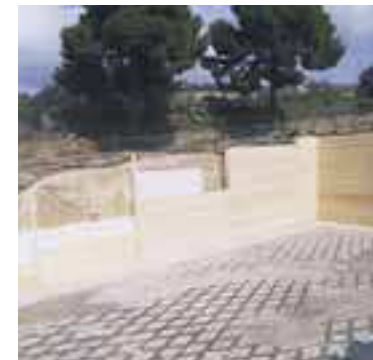
Il wafer climatico in fase di assemblaggio dei grandi pannelli coibentanti
